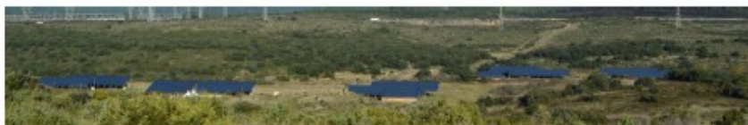
Bâtiments solaires du Mas Dieu
